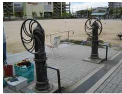
災害時には避難者の生活用水を地下の貯水槽より手動でくみ上げる。
